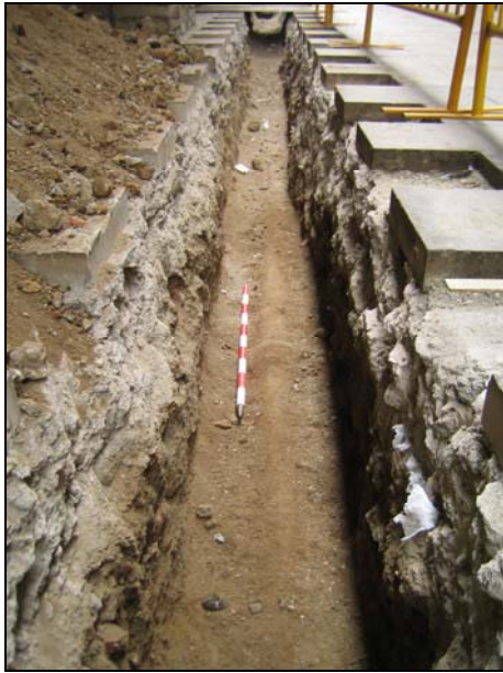
FOTO 1. Rasa 1 un cop finalitzada. S'hi pot observar l'antiga canalització UE 4.
